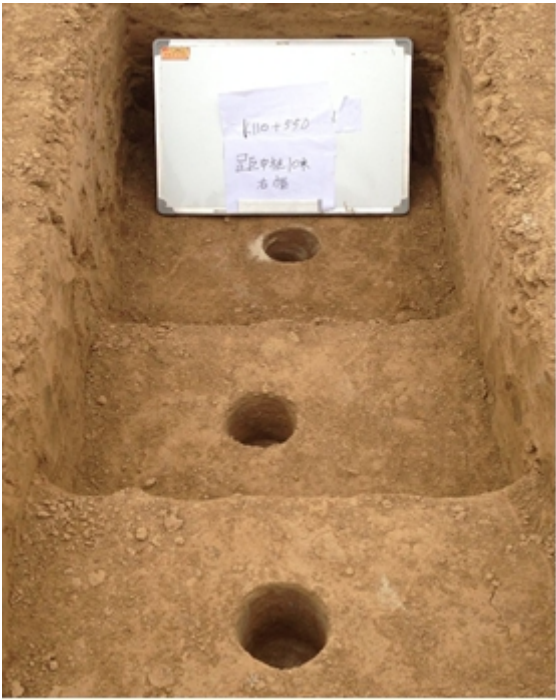
图9 济东高速公路13合同段分层分台阶检测冲压路堤压实度
