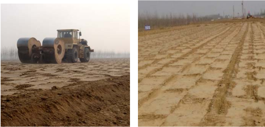
图 6 济东高速路堤冲击碾压试验段
