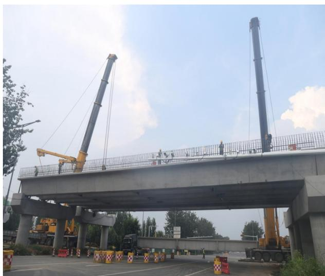
40 米箱梁吊装完成，为后续大桥架设提供了宝贵经验和技術指导，强力助推项目早日通车。
